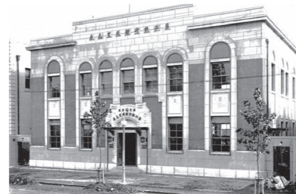
関東大震災後、再築された直後の第二銀行横須賀支店(のちの当行初代横須賀支店)現在の在日米海軍横須賀基地入口の正面にあたる。
