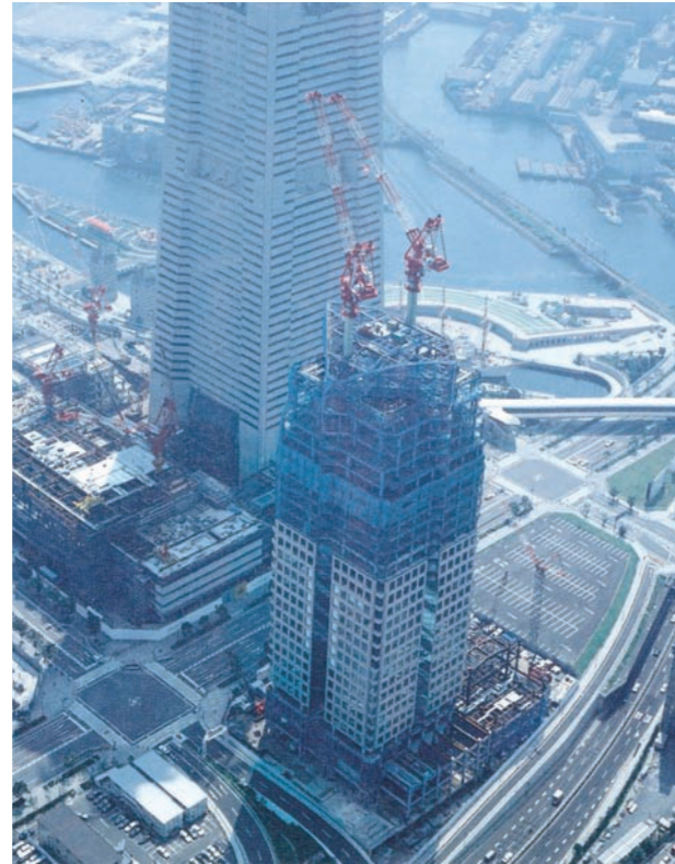
建設中の本店
