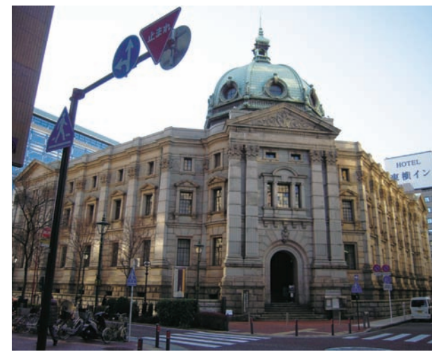
神奈川県立歴史博物館(旧横浜正金銀行本店) 南仲通五丁目60番地 明治37(1904)年落成。関東大震災ではドームを焼失するも建物は残り、戦後、東京銀行横浜支店を経て、現在も神奈川県立歴史博物館として使用されている。
