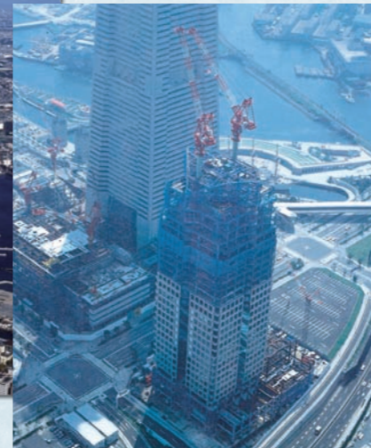
平成4(1992)年 建設中の本店
