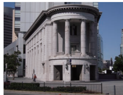
5 横浜アイランドタワー低層部
